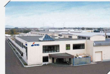
アイワードスマートファクトリー石狩工場
