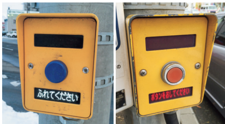
カラーユニバーサルデザインを取り入れて、見やすくなった信号機の押しボタン（左）と以前の押しボタン（右）
